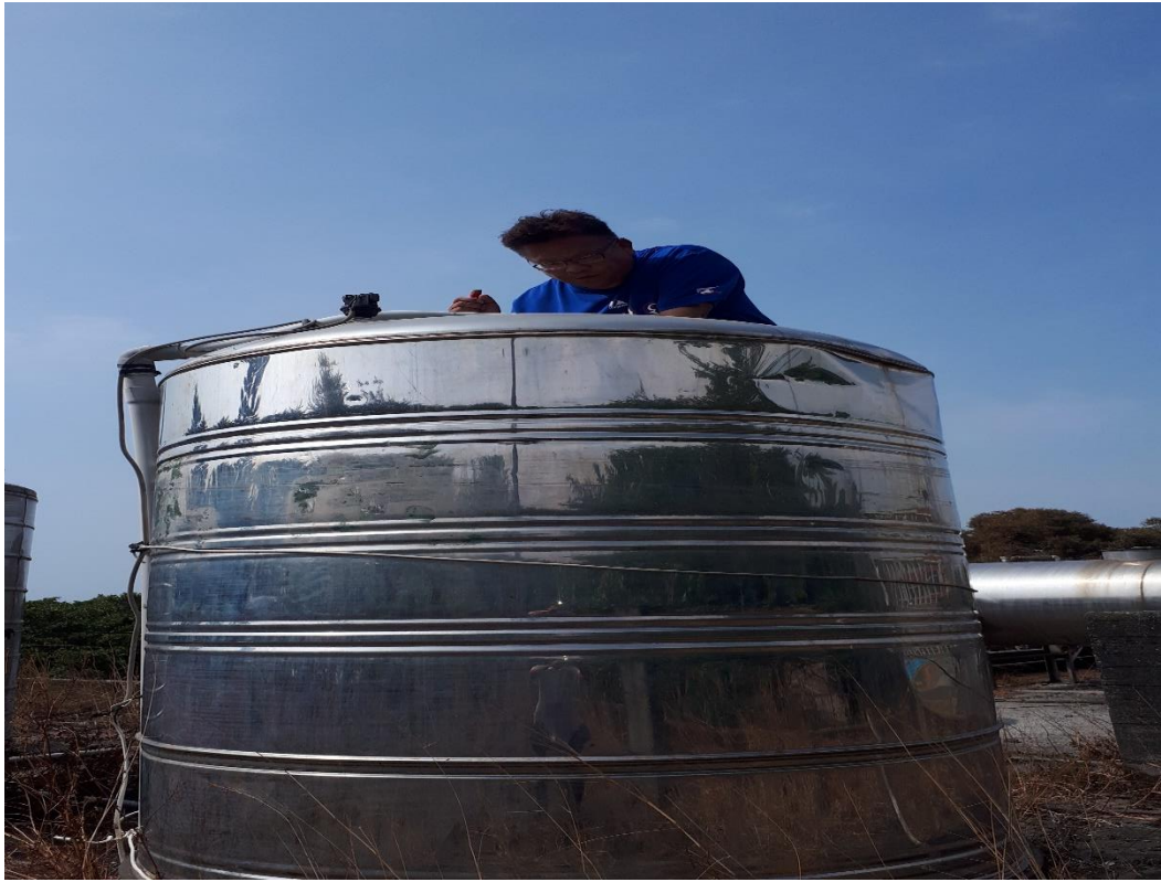
定期清洗水塔
